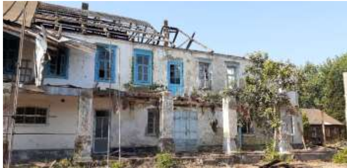
ساختمان موزه ملی خاویاری قبل از بازسازی سال ۱۳۹۸
